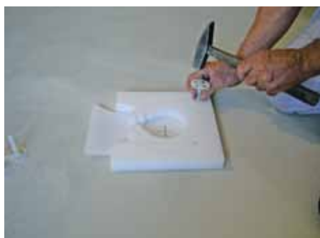
4. Прикрепить с помощью дюбелей нижнюю часть комплекта
