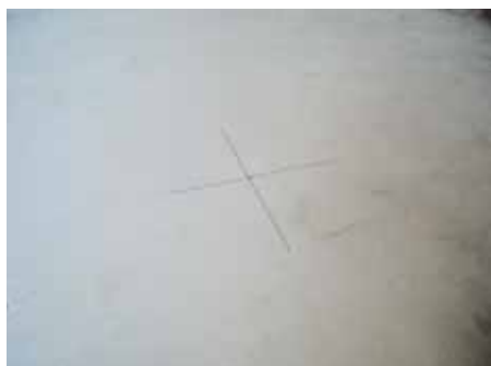
1. Отметить на плите расположение трапа
