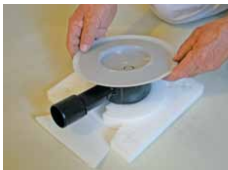
7. Установить корпус трапа с монтажной заглушкой
