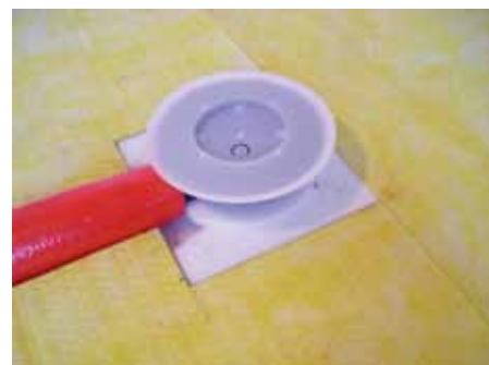
9. Уложить на плиту звукоизоляционные плиты
