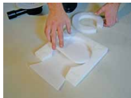
6. При необходимости увеличить высоту установки трапа
