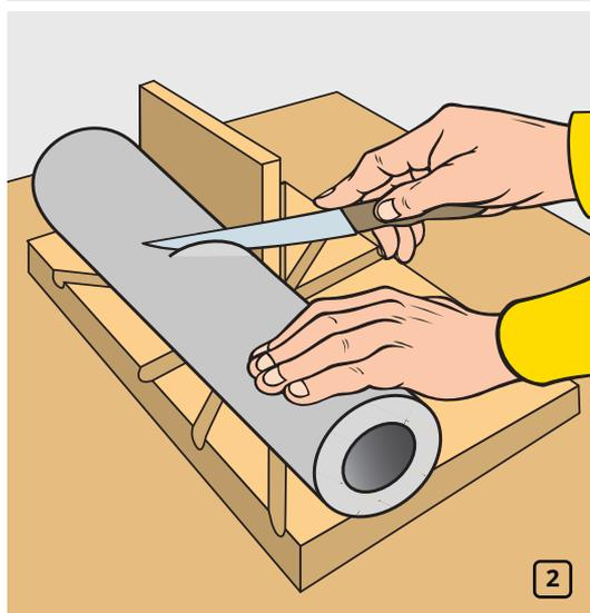
Отрежьте кусок теплоизоляционной трубки K-FLEX достаточной для изоляции угла. Длина фрагмента должна быть не меньше суммы длин катетов, образующих внешний прямой угол отвода. Разрежьте ее посередине под углом 45°. Используйте столярное стусло и нож с длинным лезвием (рис. 2)
