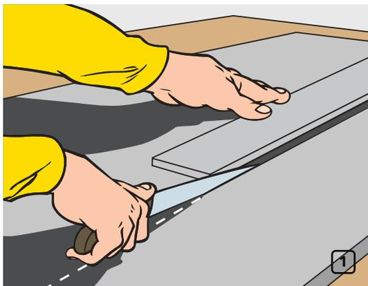
Измерьте воздуховод, перенесите полученные размеры на изоляционный лист и отрежьте от рулона необходимый для изоляции фрагмент материала (рис. 1).
