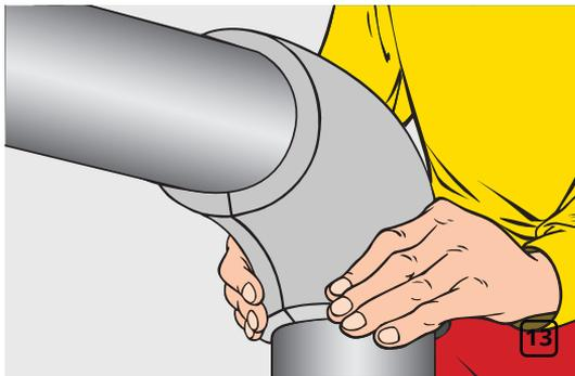
Оберните изготовленную деталь вокруг изгиба трубопровода, соедините проклеенные концы изоляционного угла и сильно сожмите их на короткое время (рис. 13).
