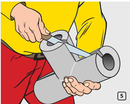
После того как клей высохнет, необходимо разрезать теплоизоляционный тройник вдоль внутренней стороны, затем установить на Т-образное соединение. Поперечные и продольные стыки проклеить (рис. 5).
