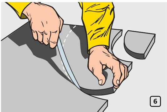
Аккуратно вырежьте по прочерченным линиям первую полусекцию изоляционного угла. Очень важно, чтобы деталь была вырезана точно по выкройке, ее края должны быть гладкими и ровными (рис. 6).
