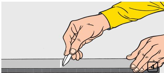
Разделите длину окружности трубы пополам и отметьте на полоске этот размер (рис. 4).
