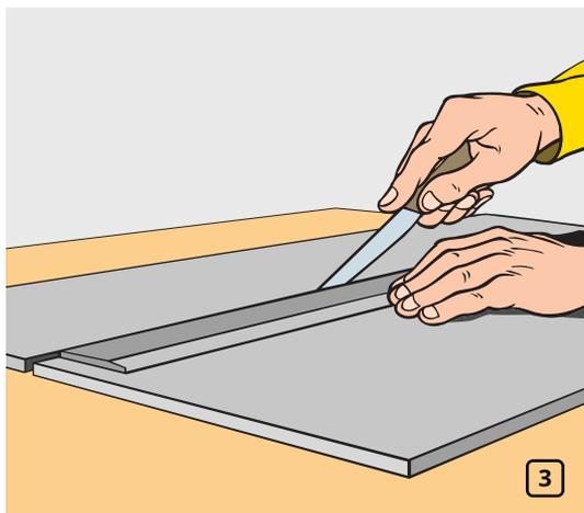
Аккуратно отрежьте материал по разметке, используя металлическую линейку для ровного реза (рис. 3).
