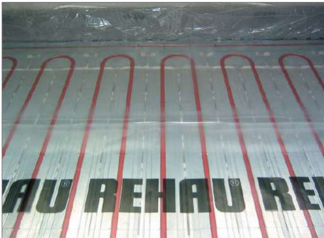
Рис. 3-59 Система укладки труб на теплоизоляционных матах TS-14
