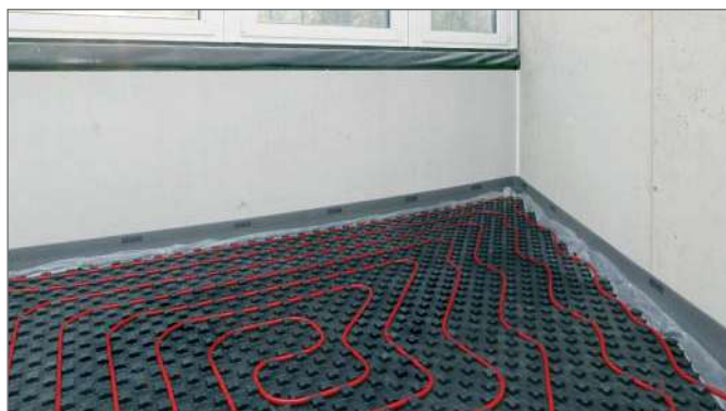
Рис. 3-11 Маты с фиксаторами Varionova с шаго-звукоизоляцией 30-2 снизу
