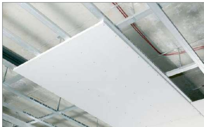
Рис. 4-5 Смонтированный потолочный элемент
