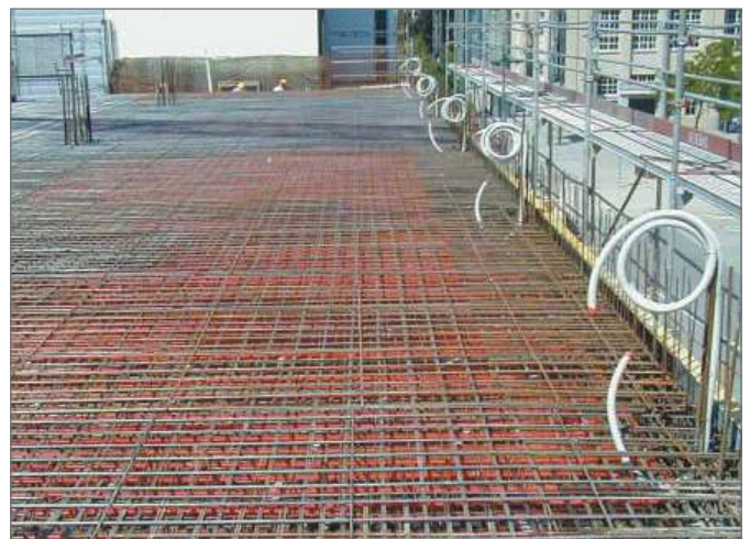
Рис. 8-2 Участок бетонирования ВКТ
