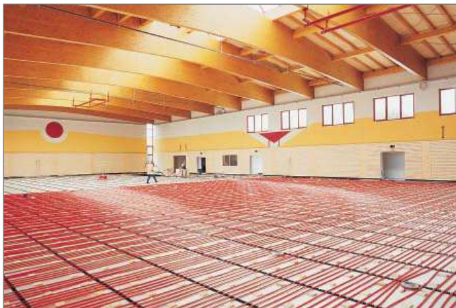
Рис. 9-17 SBH Система со стандартным распределительным коллектором
