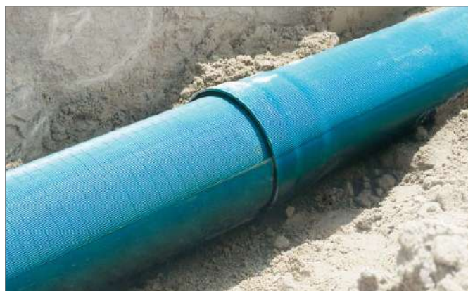
Рис. 9-33 Укладка дренажа на игровом поле
