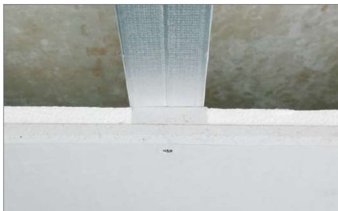
Рис. 4-6 Крепление потолочных панелей
