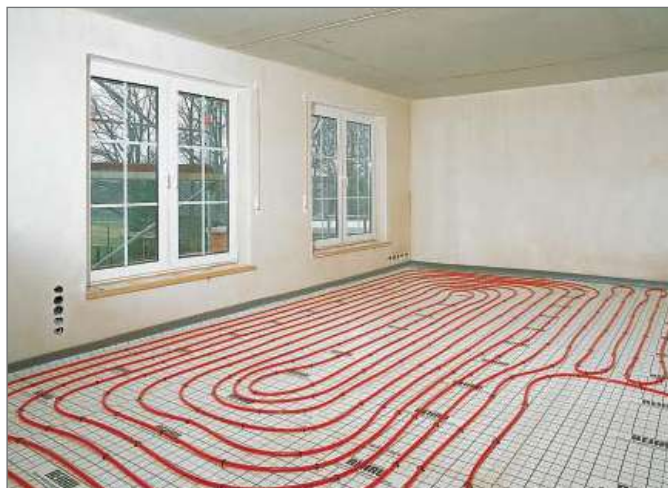
Рис. 3-22 Система крепления труб с помощью гарпун-скоб
