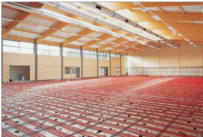
Рис. 9-23 Система SBH с трубным распределителем
