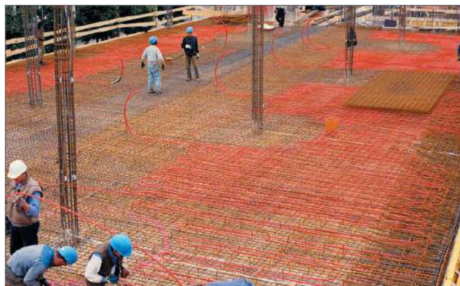
Рис. 8-5 Модули ВКТ REHAU, укладываемые на месте
